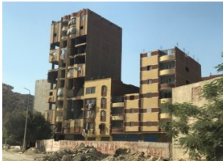
Edificios con parte de su estructura colapsada, El Cairo
